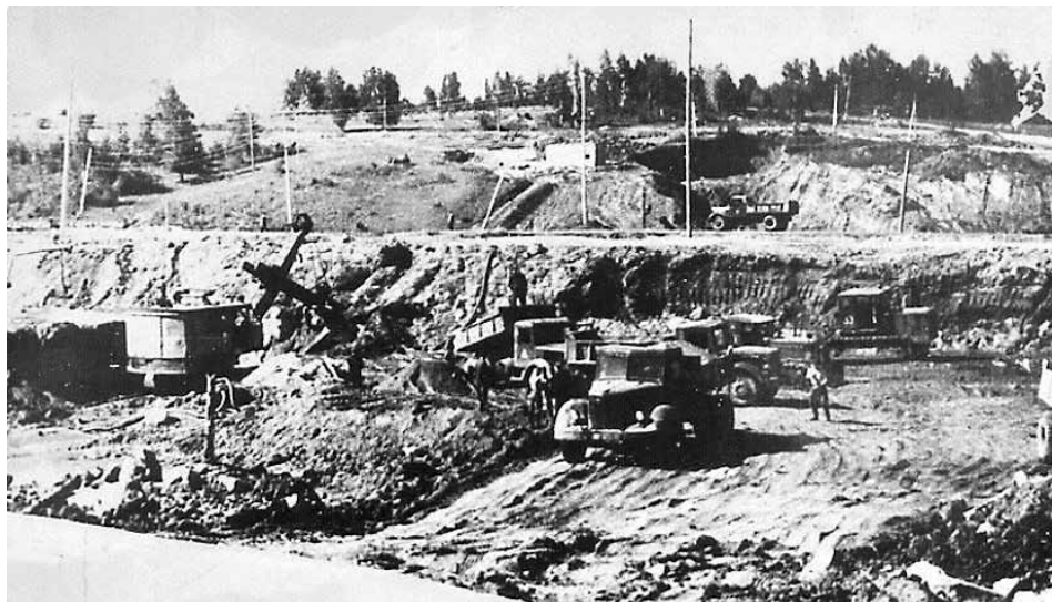
Рис. 2.99. Начало строительства БАЭС (фото предоставлено Музеем энергетики Урала)
