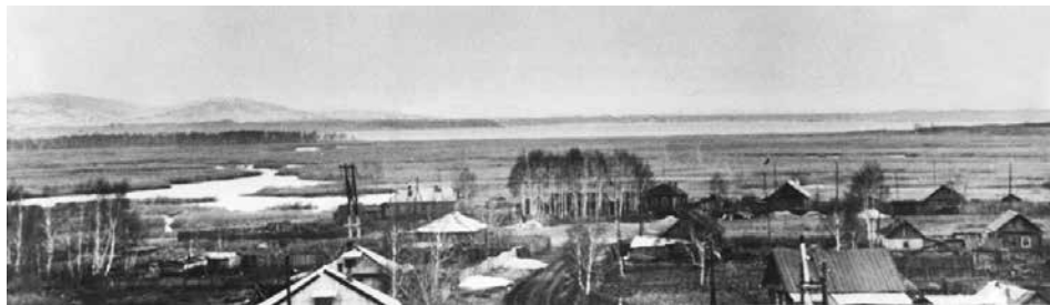
Рис. 2.35. Площадка под строительство первого реакторного завода № 817 (фото с портала [13])
