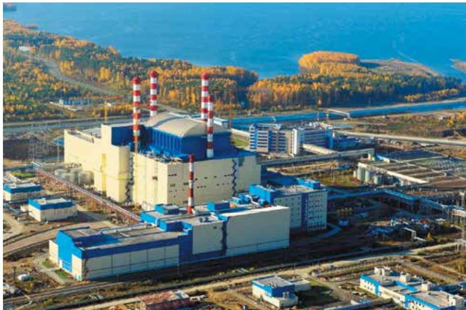
Рис. 2.102. БАЭС. БН-800 (фото из [9])
