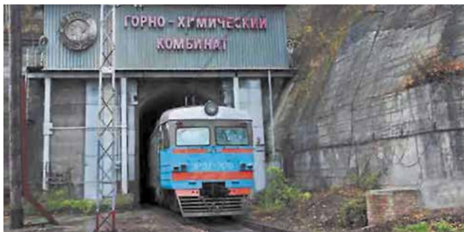
Рис. 2.73. Портал тоннеля, ведущего к подземным заводам ГХК [1]
