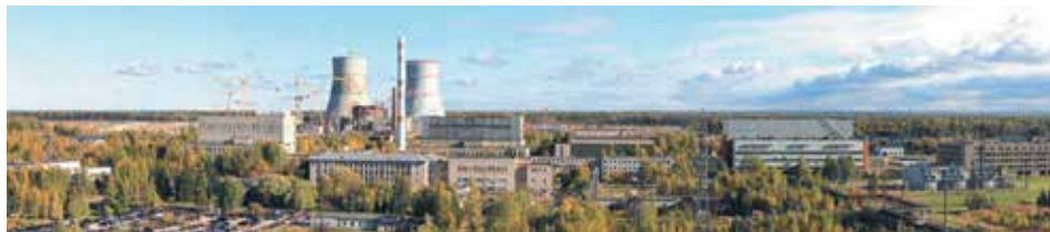
Рис. 2.157. Промплощадка НИТИ, видна высокая труба здания 104, а за ней две градирни ЛАЭС-2
